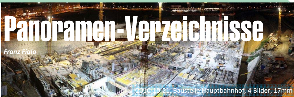
2010-10-21, Baustelle Hauptbahnhof, 4 Bilder, 17mm
