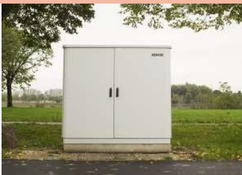
ARU der A1 Telekom (Quelle: blog.a1.net )
