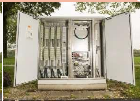
ARU der A1 Telekom, geöffnet (Quelle: blog.a1.net); links die Buchten mit der LSA Leiste (Klemmen), rechts oben der Lichtwellenleiter, rechts unten das DSLAM
