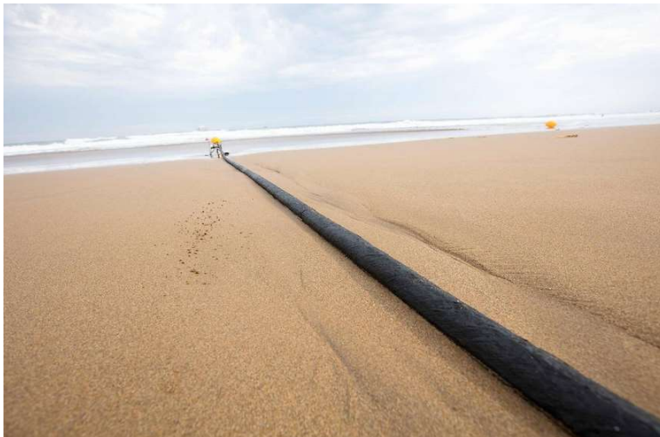
Abbildung: Hier das von Microsoft und Facebook finanzierte Projekt „Marea“. Das schwarze Kabel enthält Lichtwellenleiter und ermöglicht eine Bandbreite von 160 Tera-bit pro Sekunde (Quelle: www.orf.at , 01.08.2020)
