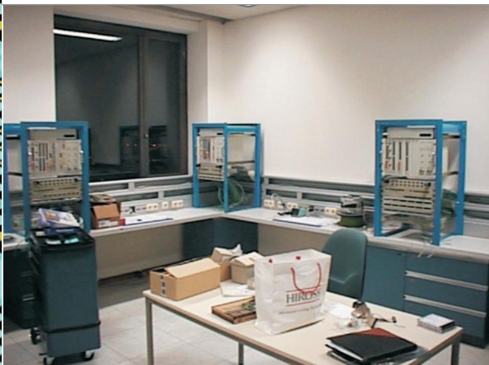
Die Racks beinhalten eine komplette Kupferverkabelung mit allen möglichen Verkabelungsfehlern. Zusätzlich wird eine komplette LWL - Verkabelung mit den Volition Komponenten mit Beginn des nächsten Schuljahres aufgebaut.
