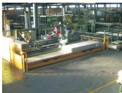
Bild 1: Totalansicht der Anlage
